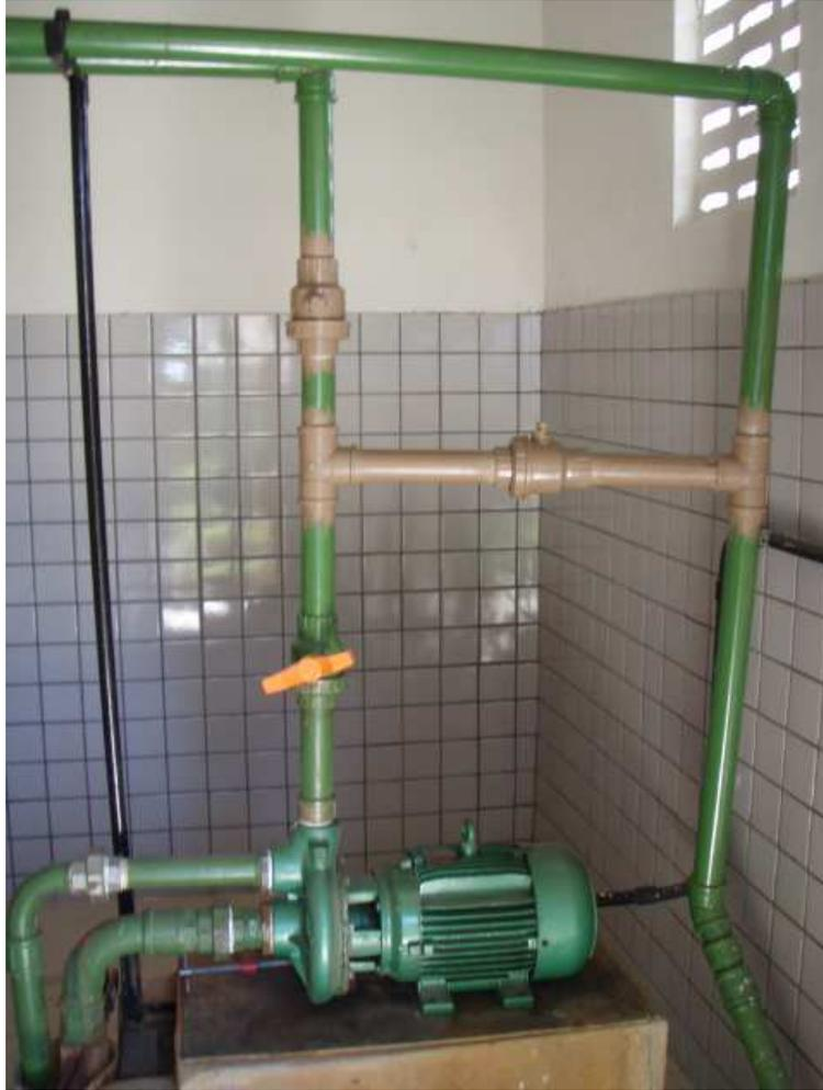
**Figura 12:** Bomba de Captação da Água Oriunda do Poço Artesiano.
