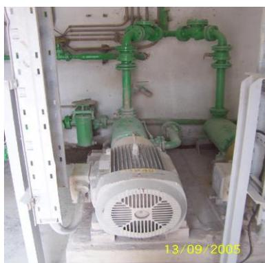
Figura 3.2.1 Bomba da torre de arrefecimento
