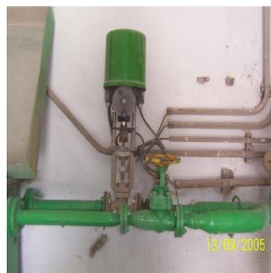
Figura 3.2.2Válvula da torre de arrefecimento
