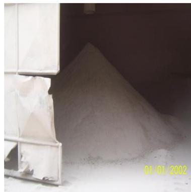
Figura 3.3.1 Sujeira da torre de arrefecimento
