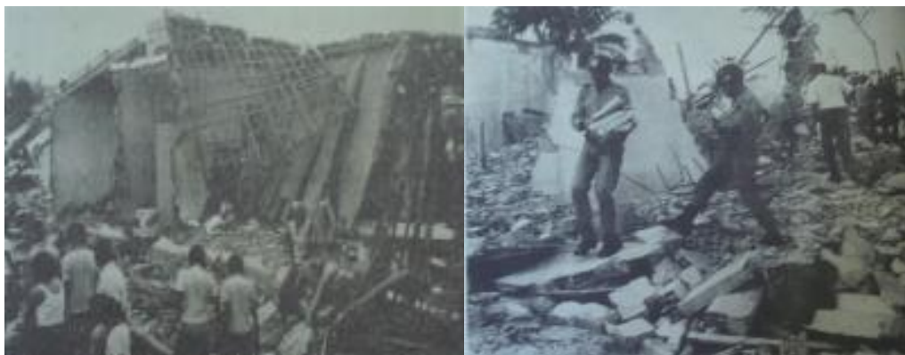
Figura 8 -Imagens dos escombros após o acidente na Avenida Explosão
