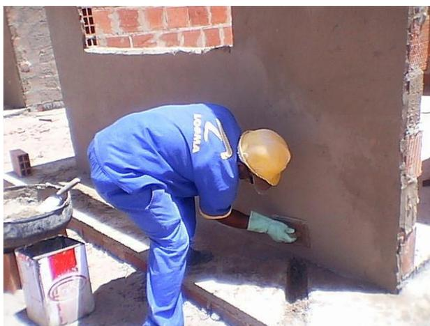
Figura 19: Aplicação de Reboco
