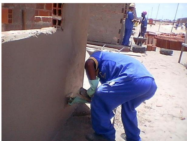
Figura 20: Aplicação de Reboco
