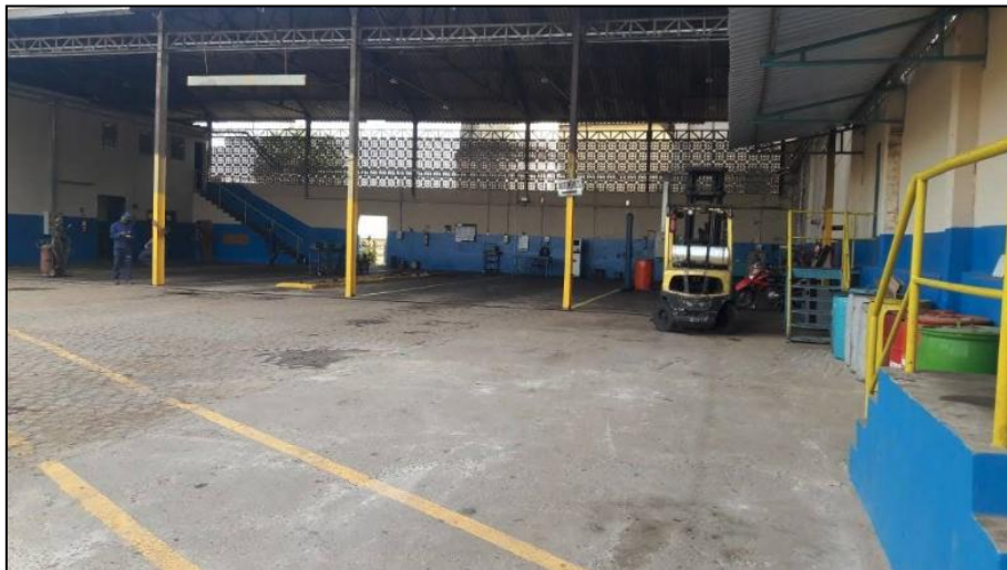
Figura 11 – Novas baias de manutenção de veículos 02
