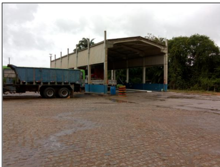
Figura 10 – Novas baias de manutenção de veículos 01
