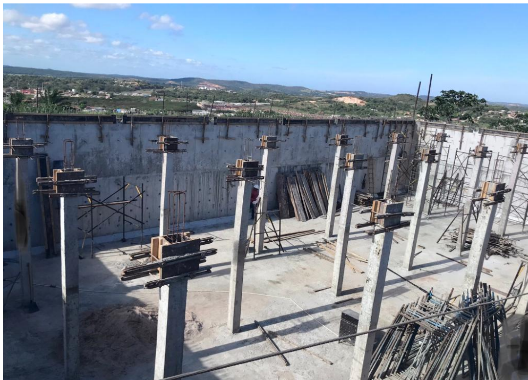
Figura 4 – reservatório em construção no município de Nossa Senhora do Socorro-SE
