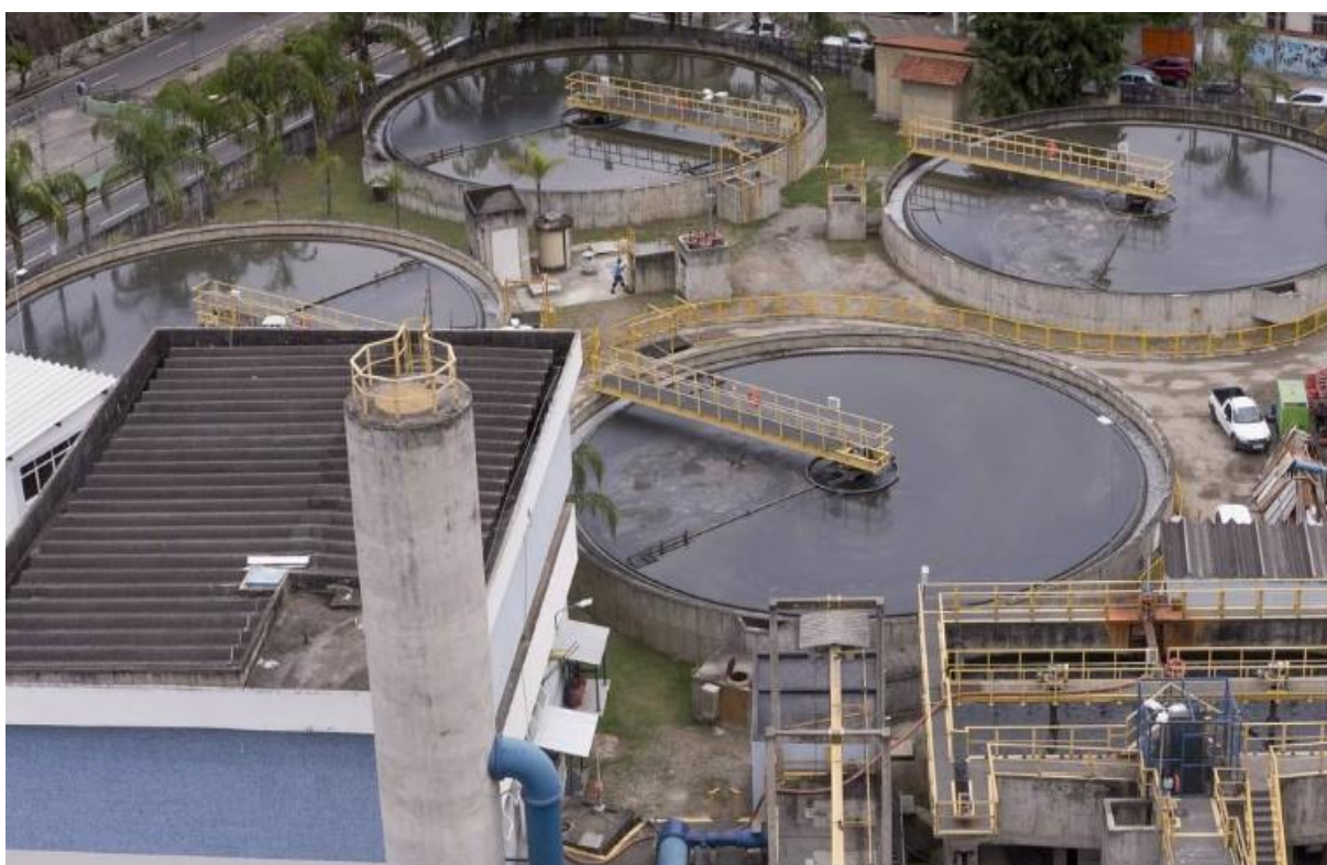
Figura 5- Estação de tratamento de esgoto.
