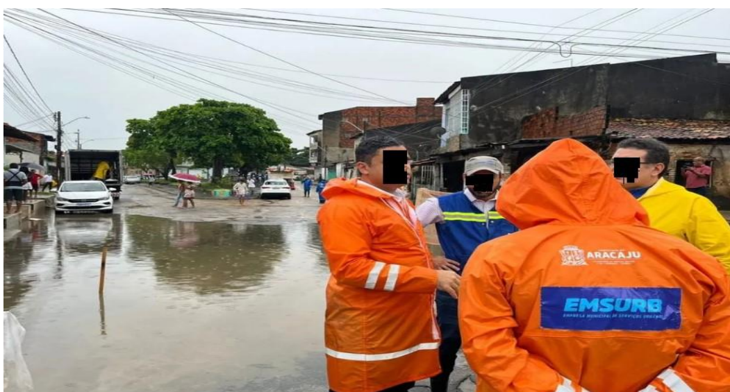
Figura 7 – Alagamento devido a incapacidade do sistema de drenagem em Aracaju-SE
