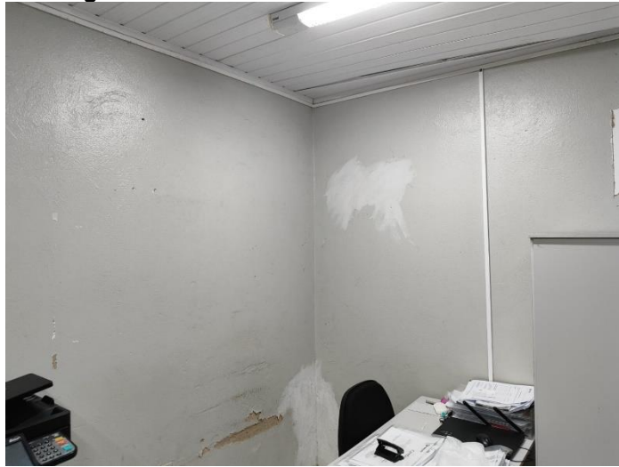
Figura 9 - Paredes do setor administrativo
