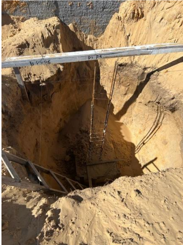
Figura 28: Sapata Isolada Concretada
