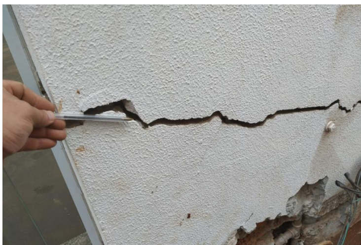
Figura 18: Recalque diferencial
