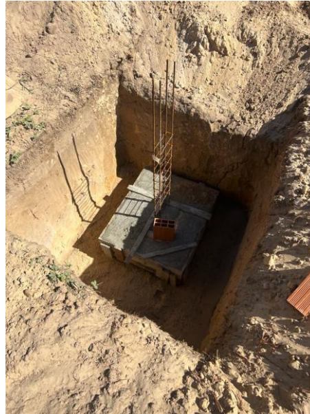
Figura 21: Sapata Isolada Concretada
