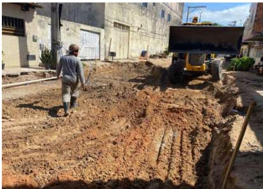
**Figura 19 – Assentamento de tubo de concreto (manilhas)**
