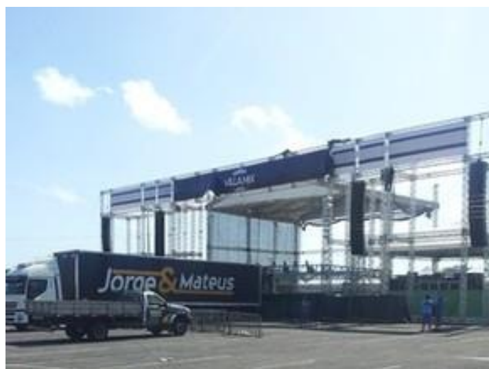
Figura 17: Carreta em montagem de palco
