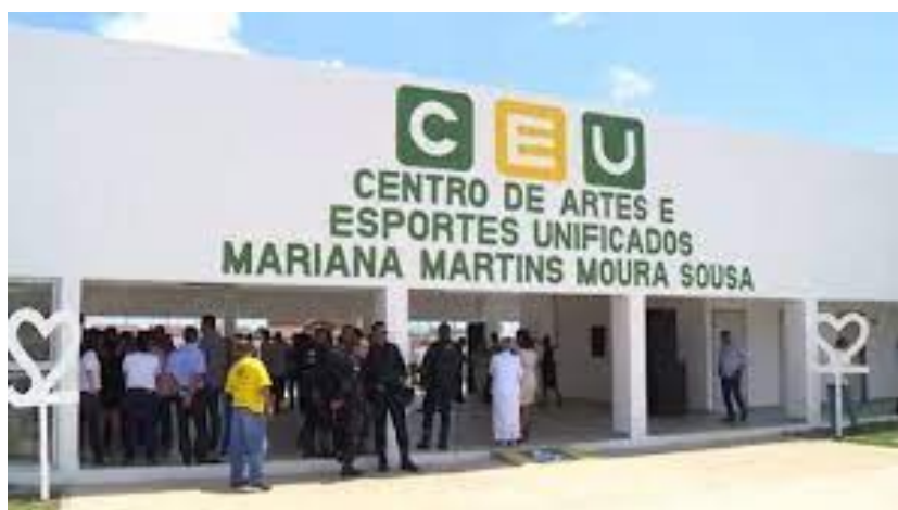
Figura 2 – Centro de Artes e Esportes Unificados (Aracaju/SE).
