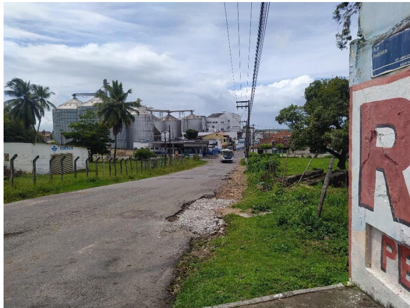
Figura 62 – Ausência de sinalização na rua Fortaleza
