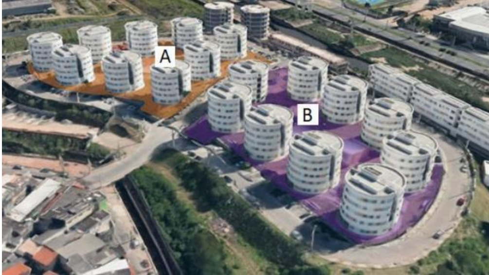
Imagem 32: Implantação do Residencial Heliópolis I – Vista aérea.
