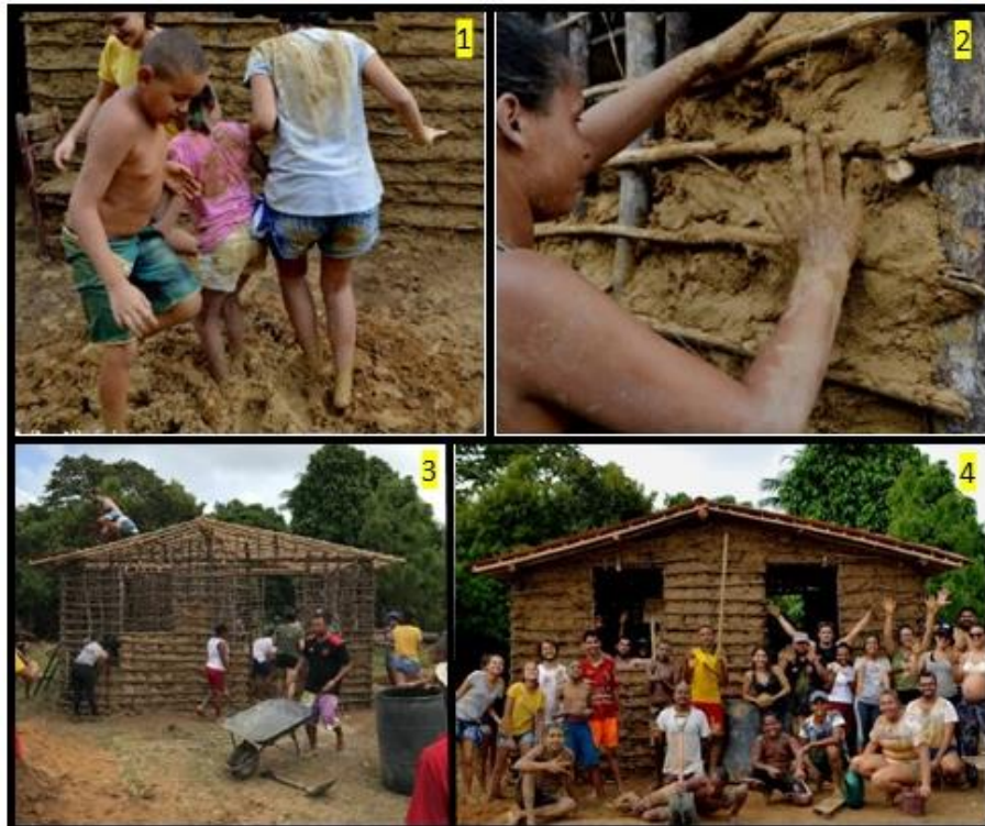
Imagem 22: Processo construtivo da casa de taipa de mão.
