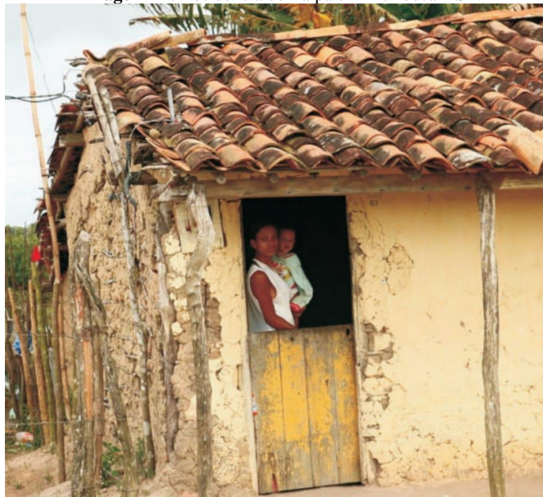
Imagem 21: Residência de Taipa em Muribeca – SE.
