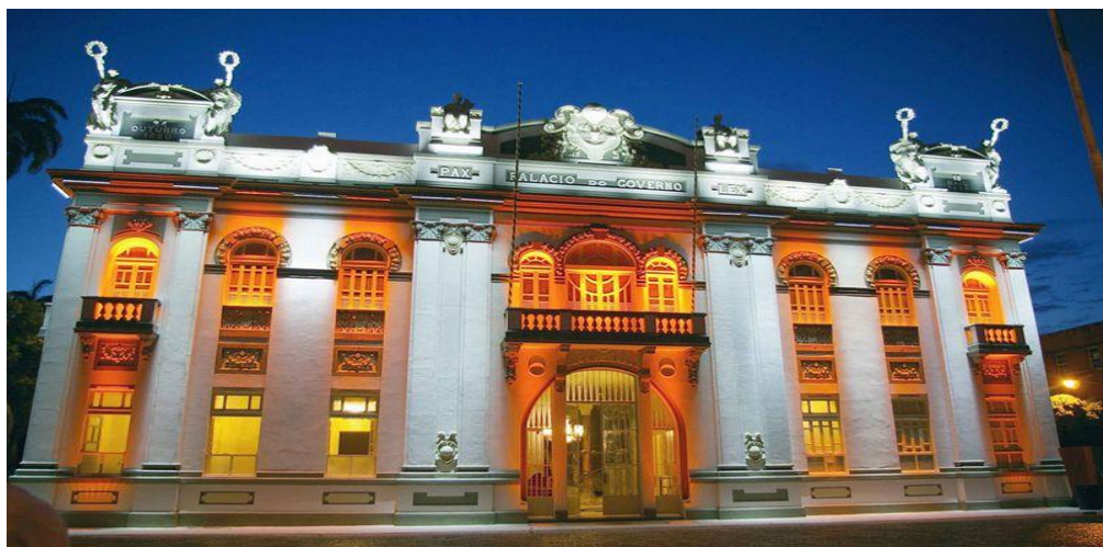
Figura 14 – Fachada iluminada após restauração
