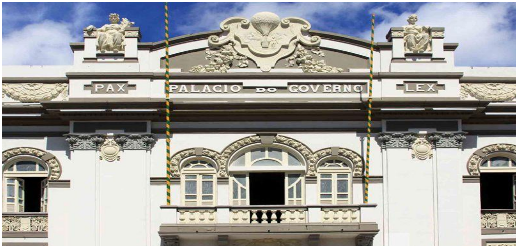
Figura 16– Sacada da fachada
