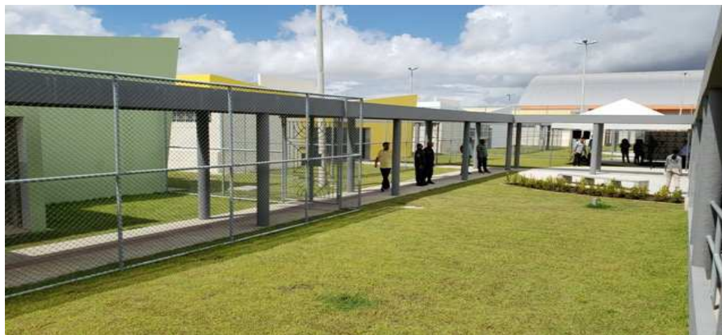
FOTO 2- Entrada da CASEM
