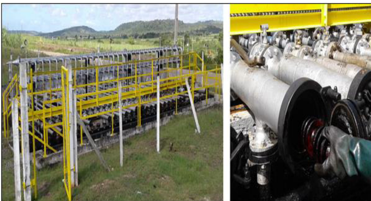
Figura 17 - Introdução do PIG na câmara do LC-1 localizada no satélite 1
