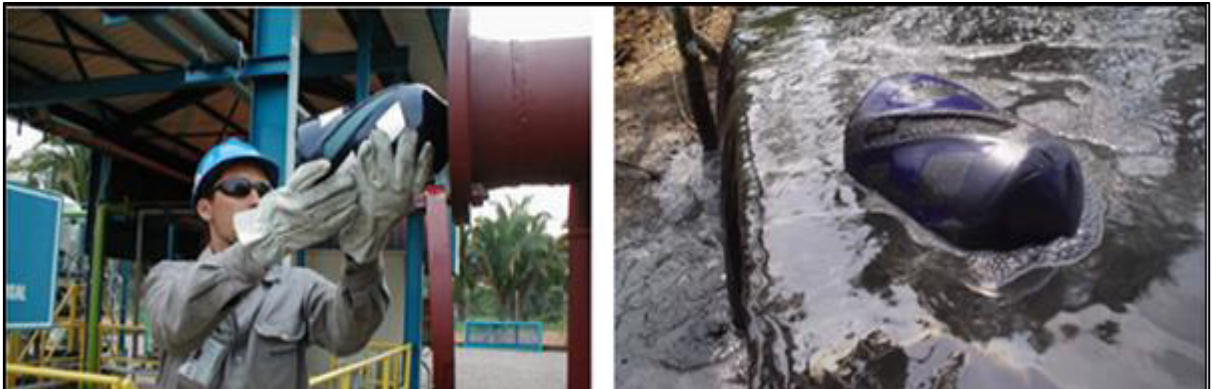
Figura 12 - Inserção e retirada do PIG após atravessar e limpar um duto
