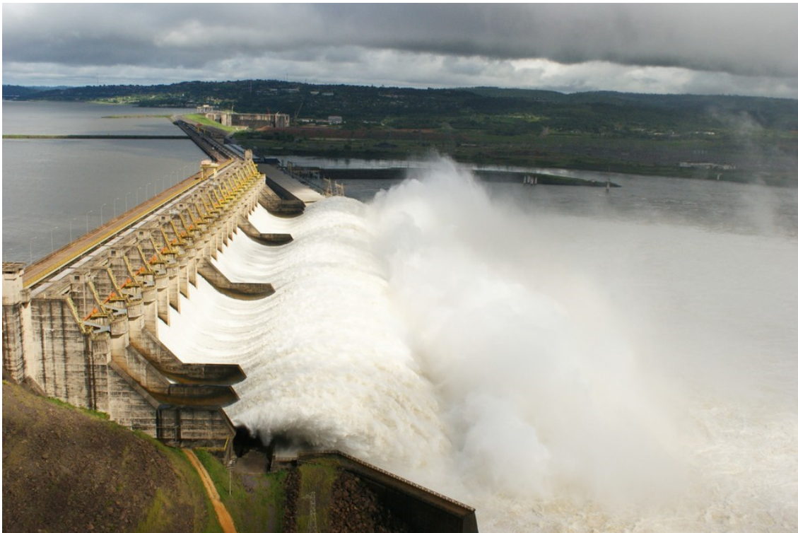
Usina de Tucuruí, no Pará (Foto: Divulgação)
