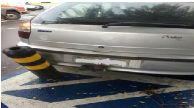
Figura 23 - Balizador danificado
