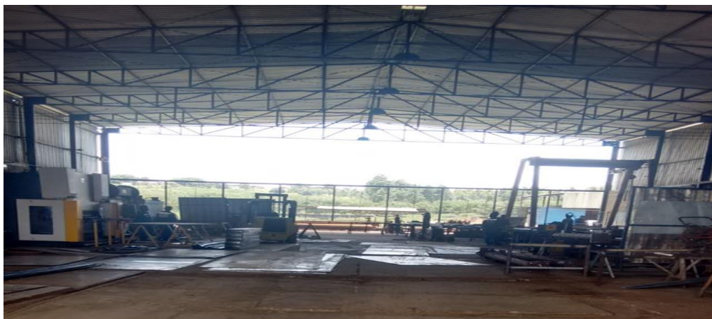
Figura 6 - Galpão da Metalúrgica Cloves Ltda.
