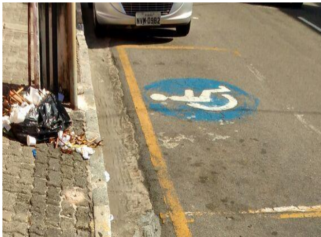
FIGURA 03 – VAGA RESERVADA COM UM POSTE NA ÁREA DE CIRCULAÇÃO DE VEÍCULO
