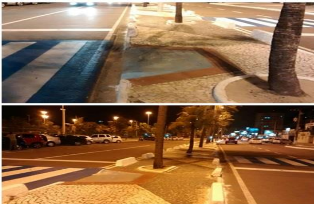
Fotografia 9- Rampa não acessível. Apesar de existir a rampa, no trajeto que dá acesso a uma e outra faixa de pedestre há uma barreira física, qual seja, um coqueiro. Orla de Atalaia.
