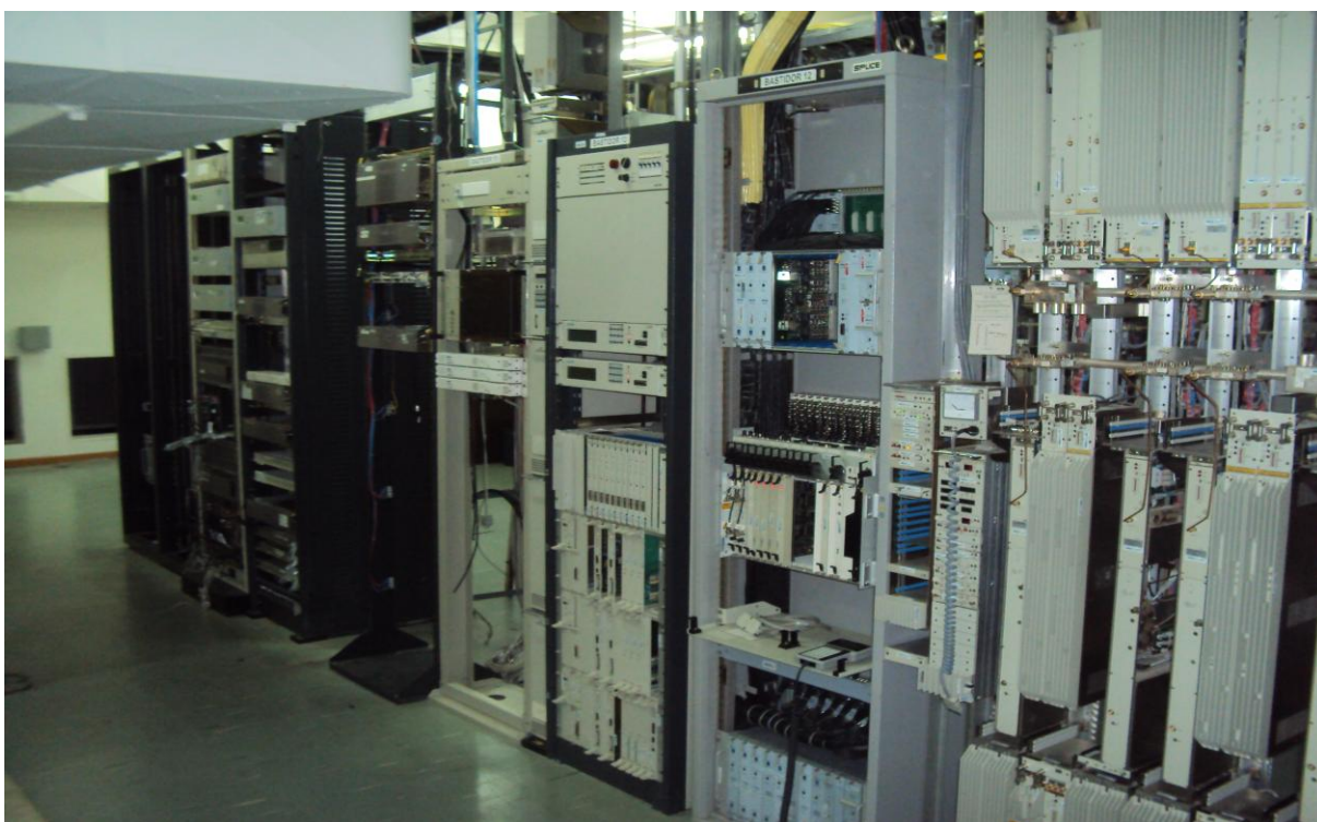
Figura 9 – Área interna da estação SMB FA
