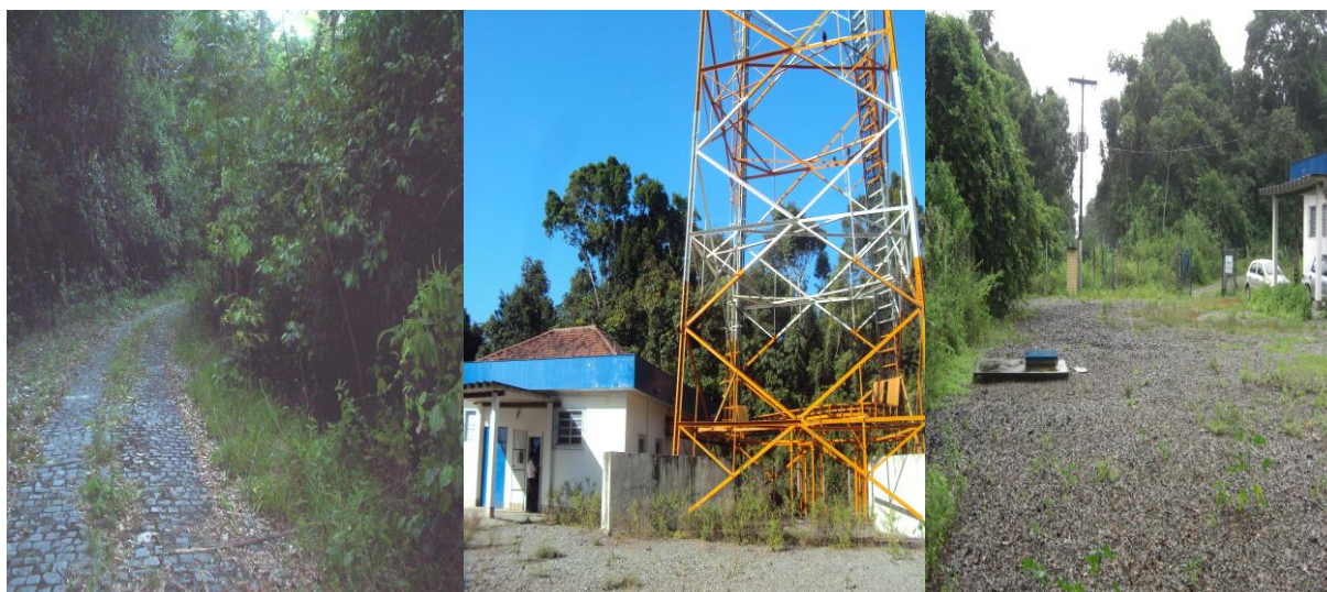
Figura 12 – Estrada de acesso à estação SMB FA e área externa
