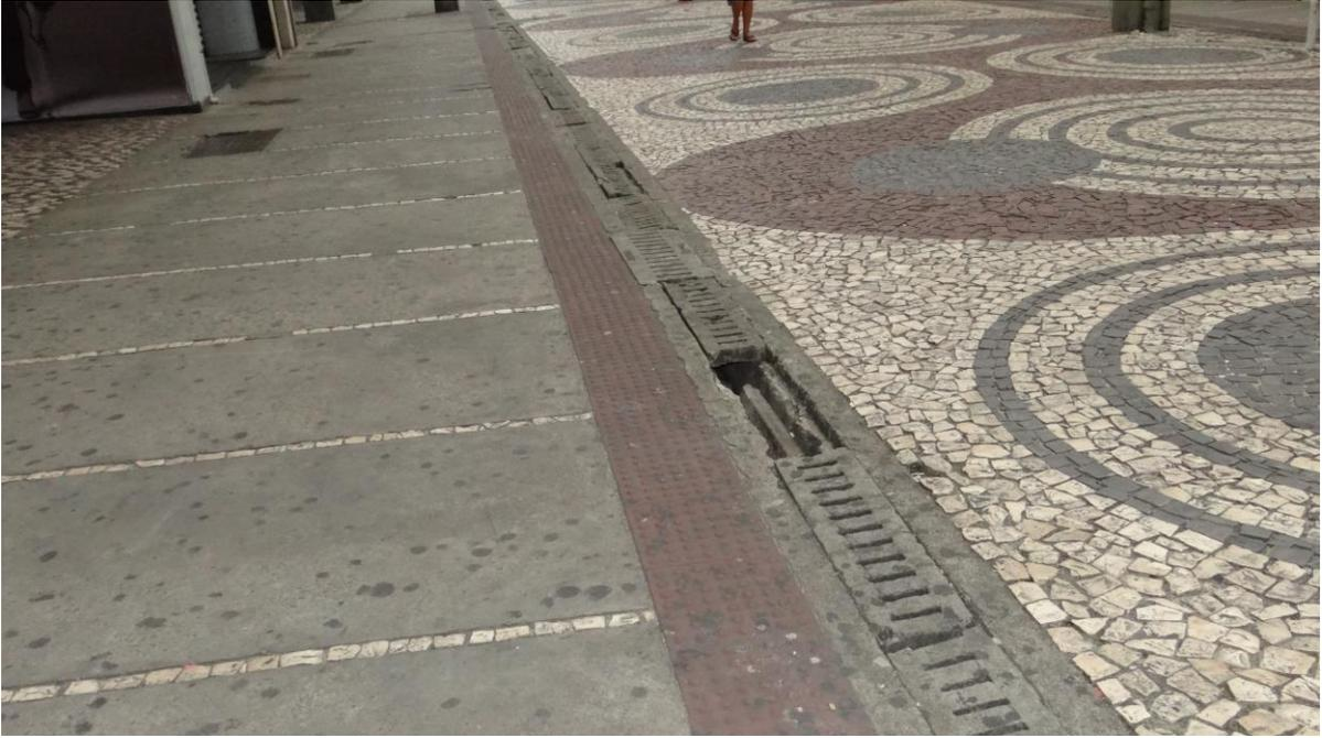
**Figura 17 - Buracos nas tampas de esgoto.**
