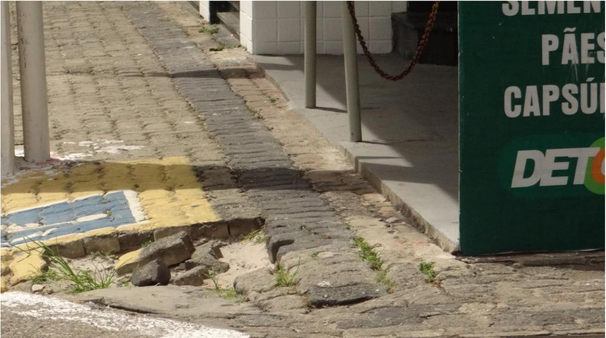
**Figura 33 - Má conservação de rampa e buraco na calçada.**
