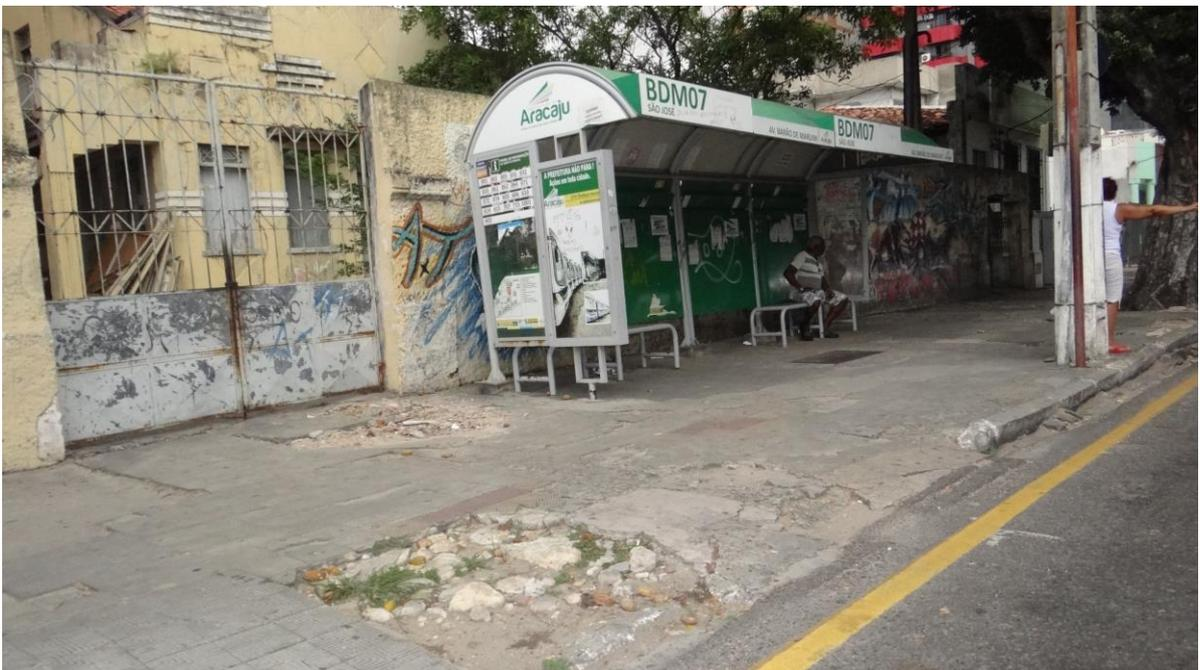
**Figura 36 - Má conservação de rampa, buraco na calçada e sinalização deficiente.**
