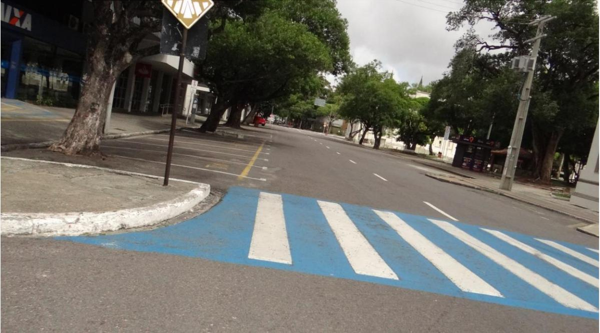
**Figura 29 - Inadequação de faixa de pedestre e acesso a calçada.**
