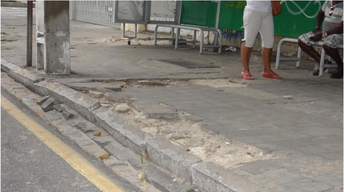
**Figura 35 - Má conservação da calçada em parada de ônibus.**
