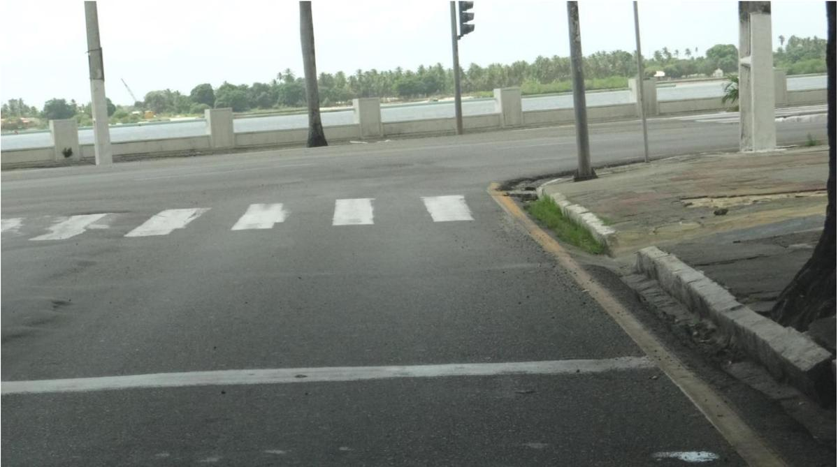
**Figura 37 - Inadequação de faixa de pedestre e rampa.**
