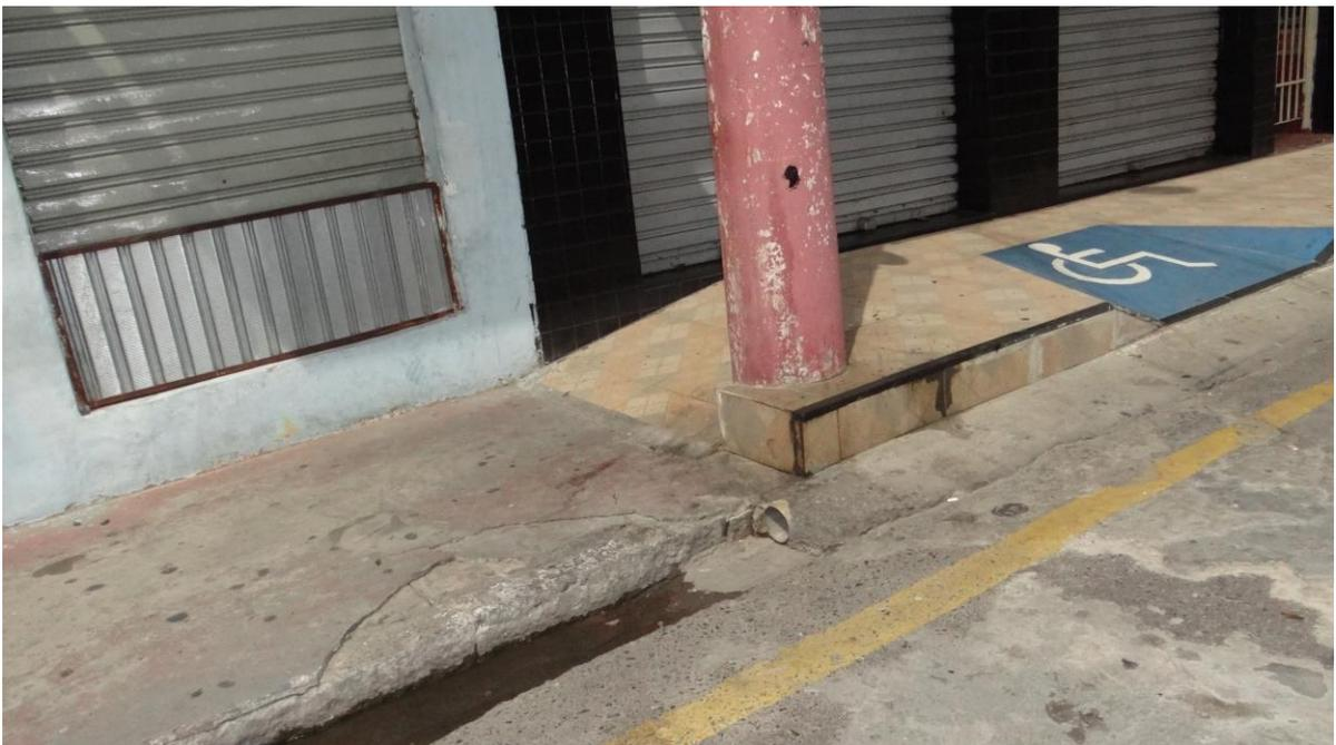
Figura 2 - Calçada estreita e rampas inadequadas.
