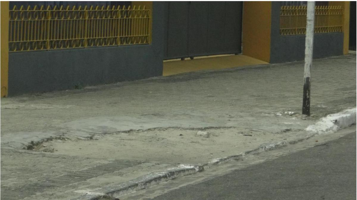
**Figura 34 - Má conservação de rampa e buraco na calçada.**
