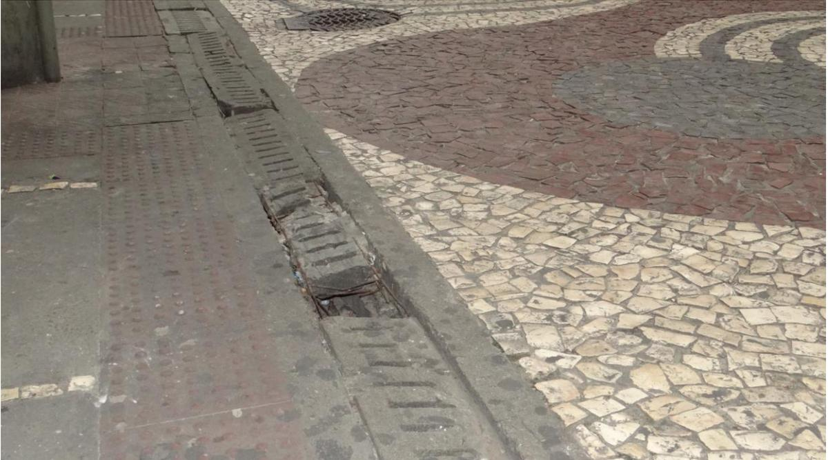
**Figura 19 - Buraco nas tampas de esgoto.**
