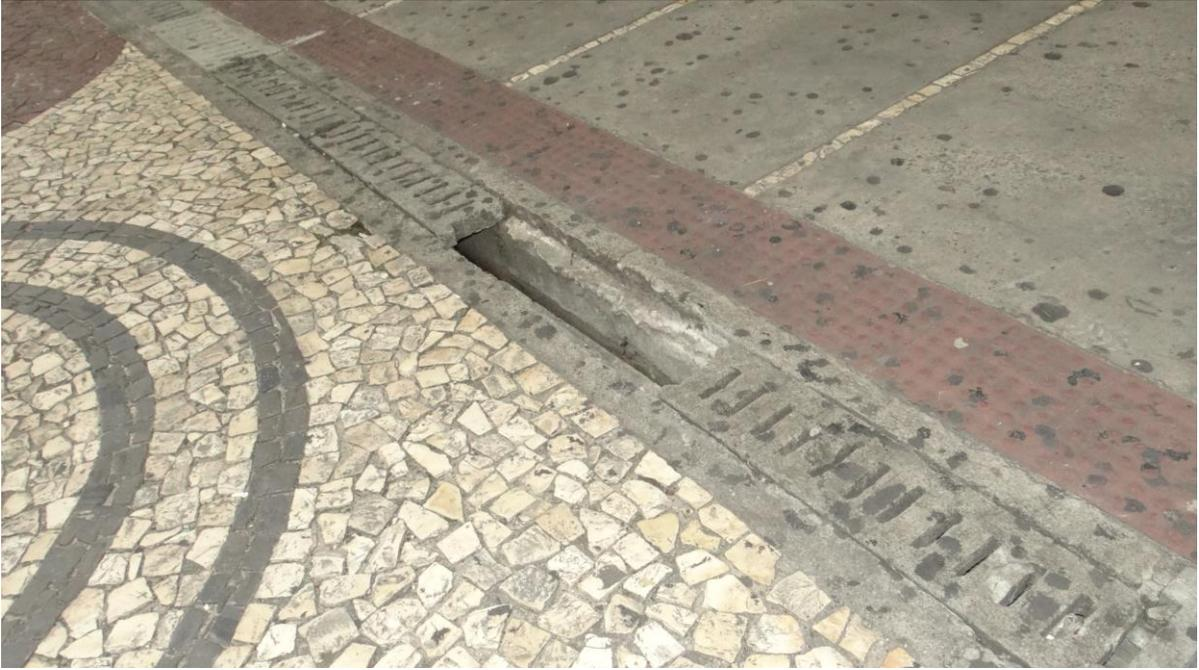
**Figura 21 - Buraco na tampa de esgoto.**
