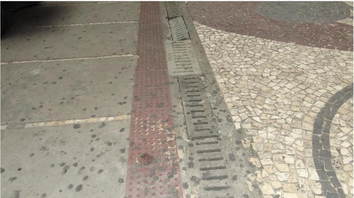
**Figura 16 - Tampas de esgoto sem conservação.**
