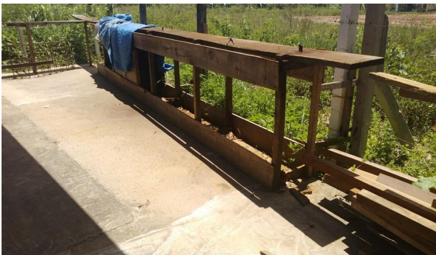
Figura 7 Área para serviços de armação em aço
