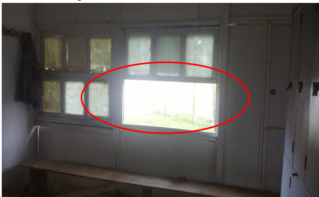
Figura 16 Janelas existentes no vestiário
