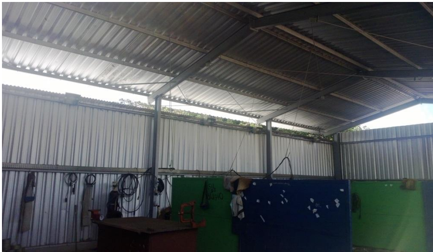
Figura 6 Galpão de caldeiraria
