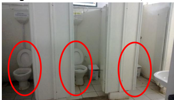
Figura 12 Vasos sanitários 1, 2 e 3
