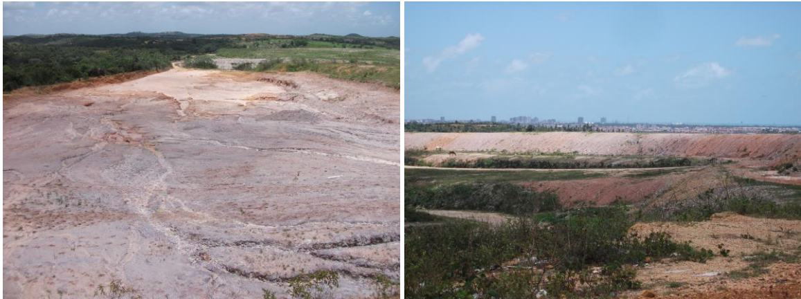
Figura 1 - Vista do lixão Santa Maria, desativado desde abril de 2013
