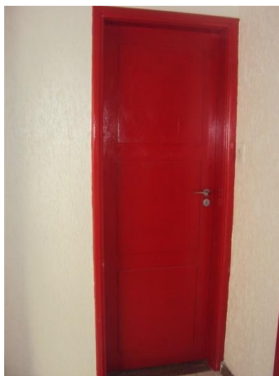
Figura 12 – Porta colocada no setor de estoque da SECOM
