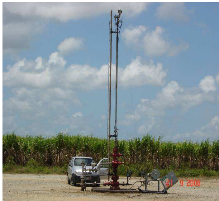
Figura 06: Vista geral do poço equipado com UDM
