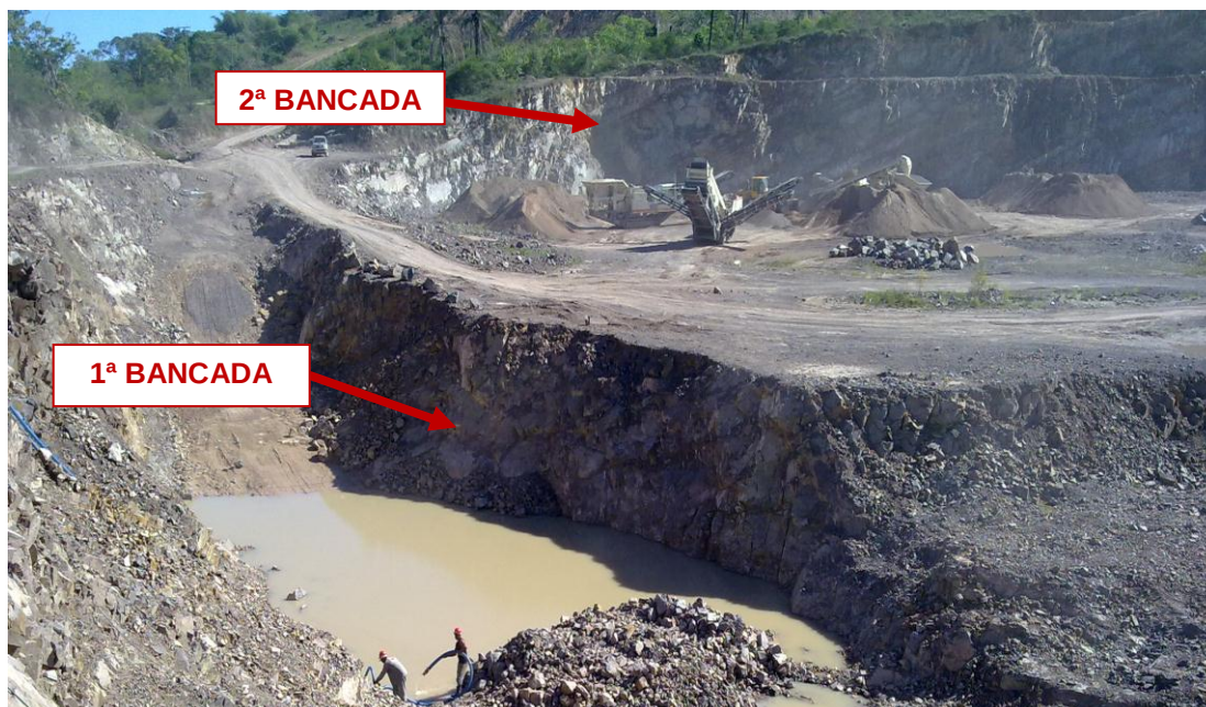
Figura 7 – Bancada da Mina Detonada
