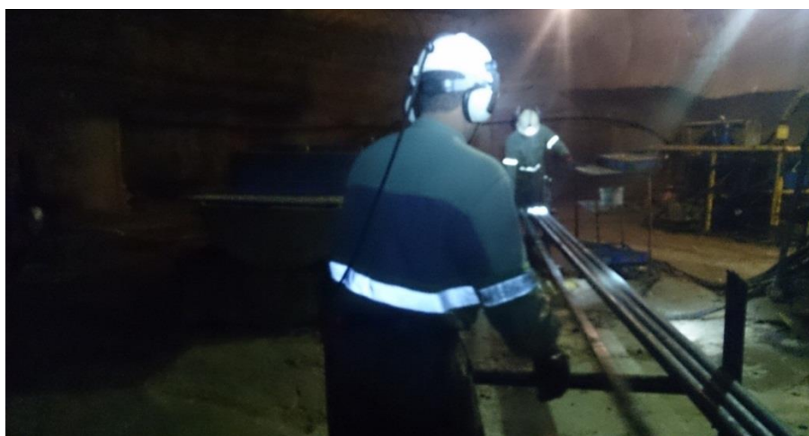
Figura 9 – Colocação da haste em cavalete
